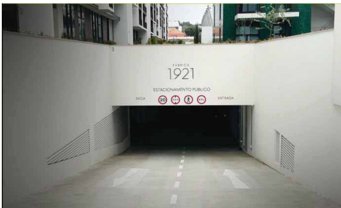
Figura 2-17 Parque de estacionamento Fábrica 1921, em Benfica
