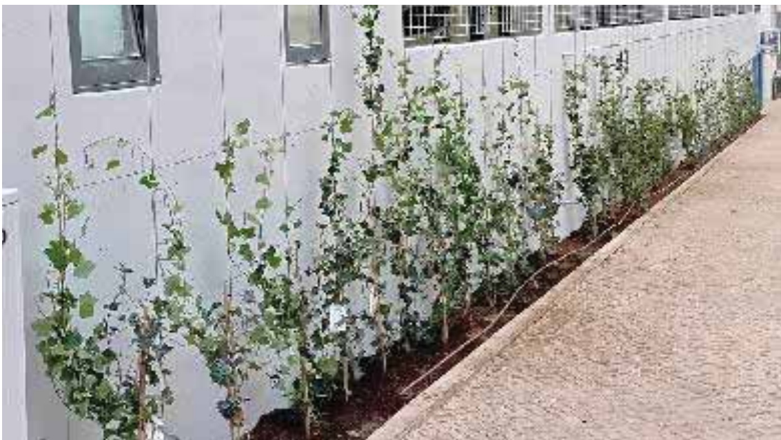
Figura 2-16 Parque de Estacionamento do Bahuto, em Campo de Ourique
