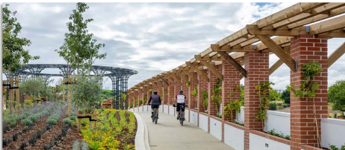
FIGURA 4-4 PASSAGEM CICLO PEDONAL DA AV. ALMIRANTE GAGO COUTINHO INAUGURADA NO ANO DE 2025
