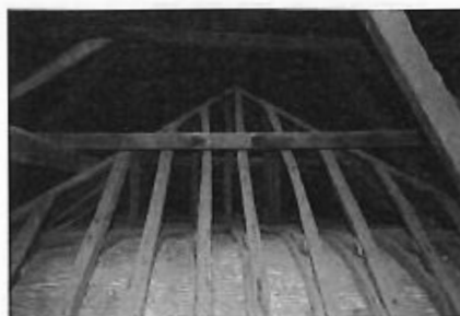
Fig. 15. Fotografias com as estruturas dos telhados “em tesouro” sob a atual cobertura de duas águas, in Mariana, 2007, pág. 109.
