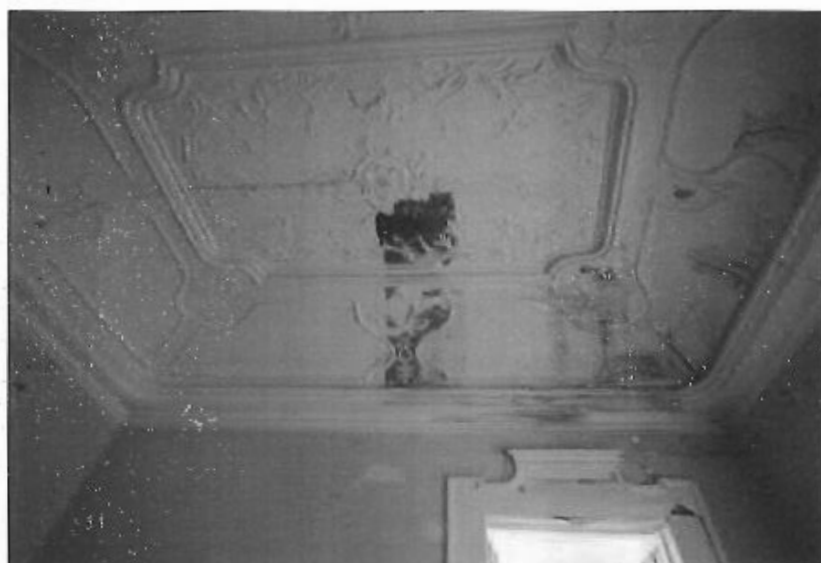
Fig. 31. Janela de Sondagem aberta no tecto da sala dos pássaros revelando ricas policromias sob tinta de cor branca, in Mariana, 2007, pág. 137.
