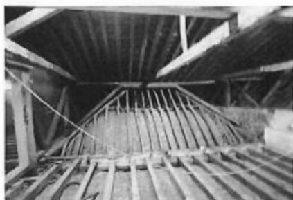
Fig. 15. Fotografias com as estruturas dos telhados “em tesouro” sob a atual cobertura de duas águas, in Mariana, 2007, pág. 109.
