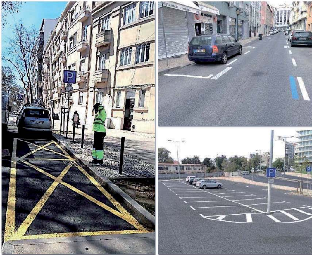
FIGURA 2-11 8 REPINTURA DE LUGARES - BOLSA DE CARGAS E DESCARGAS, LUGARES DE RESIDENTES E LUGARES TARIFADOS
