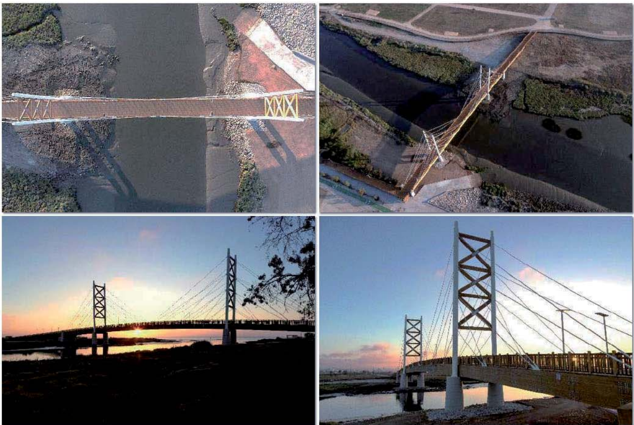
FIGURA 3-5 IMAGENS DA PONTE CICLOPEDONAL SOBRE O RIO TRANCÃO
