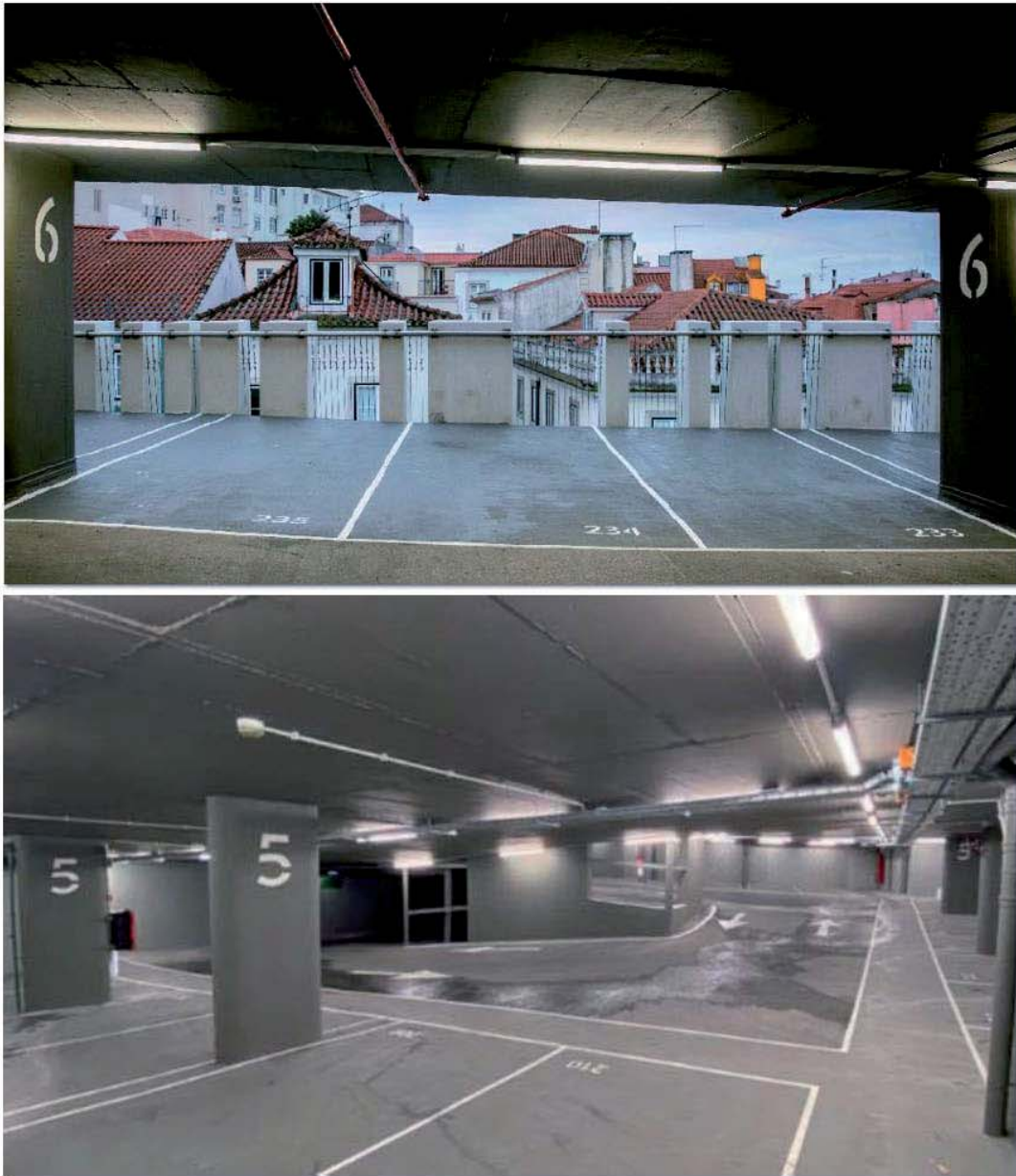
FIGURA 2-9 PISOS SEIS E CINCO DO PARQUE DA CALÇADA DO COMBRO
