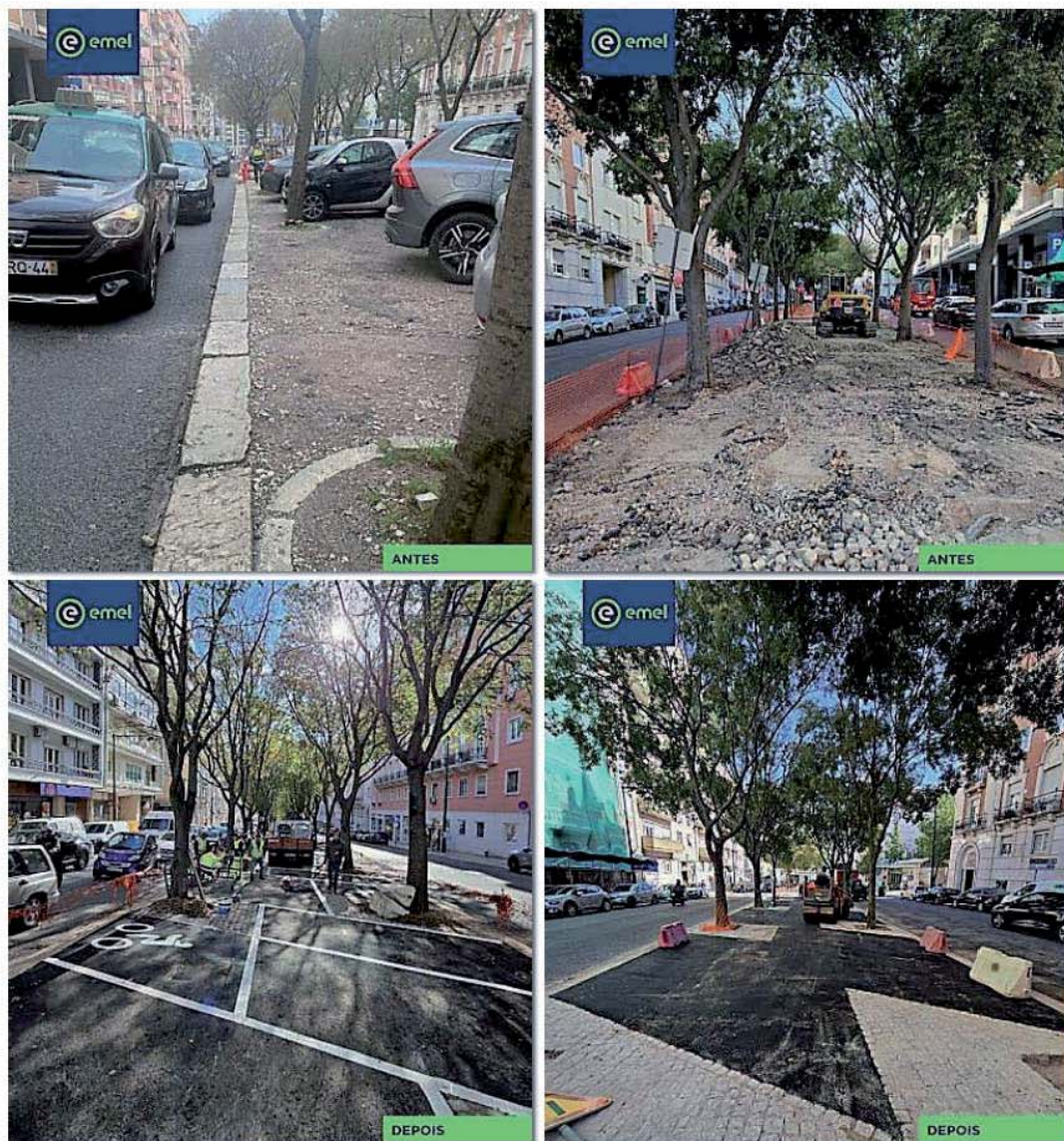
FIGURA 2-1 INTERVENÇÃO NA PLACA CENTRAL DA AVENIDA ANTÓNIO AUGUSTO DE AGUIAR
