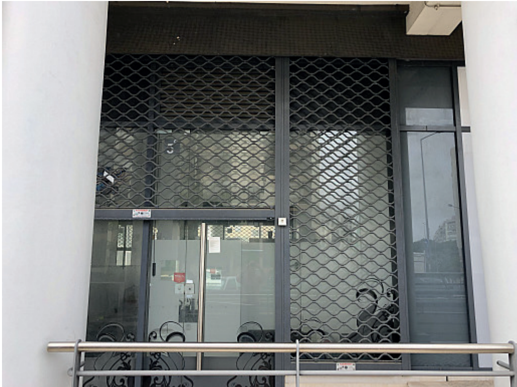
Fotografia da fachada
