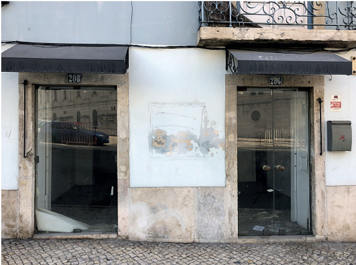
Fotografia da fachada
