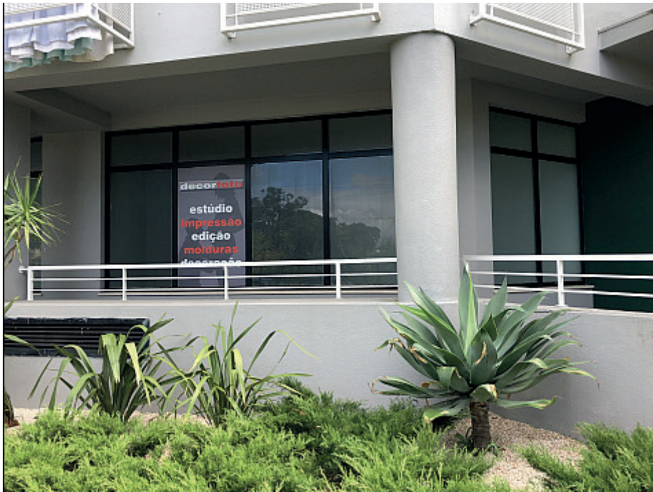
Fotografia da fachada
