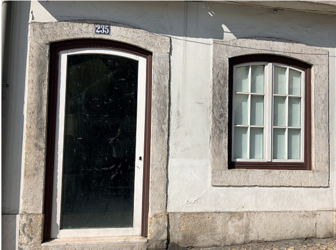
Fotografia da fachada
