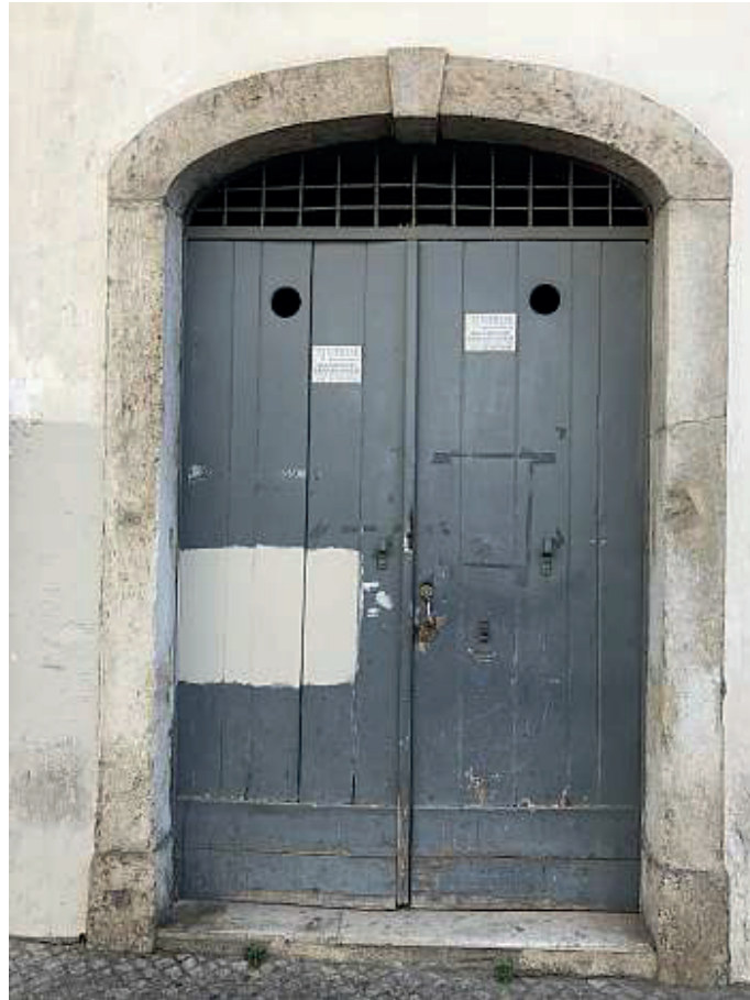
Fotografia da fachada
