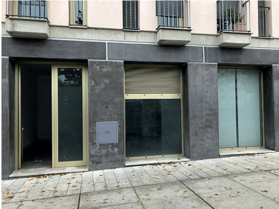
Fotografia da fachada
