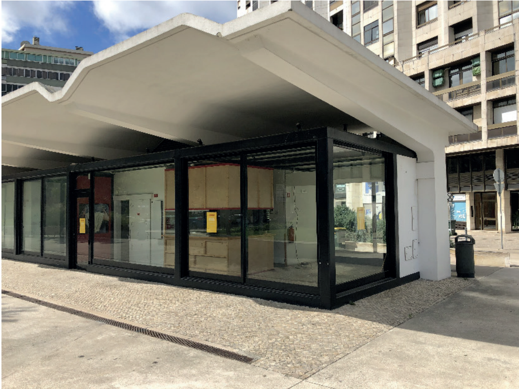
Fotografia da fachada
