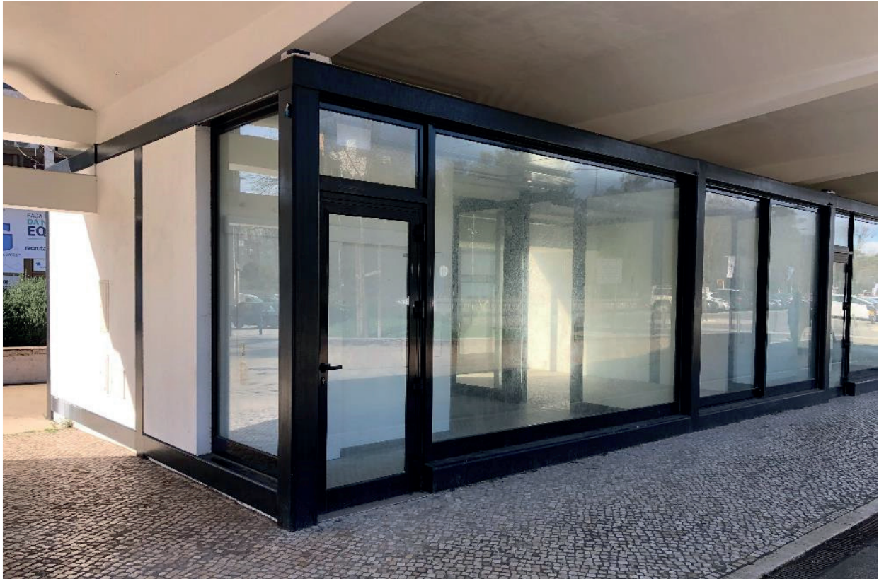
Fotografia da fachada
