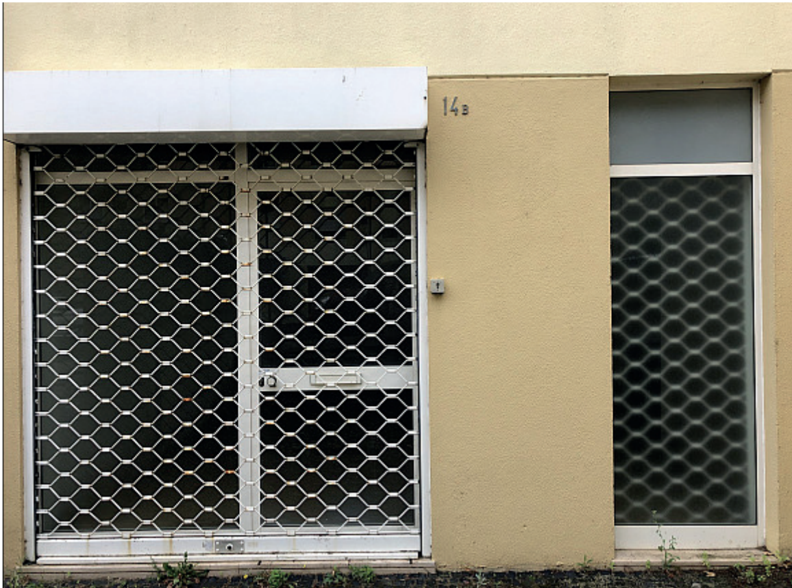
Fotografia da fachada
