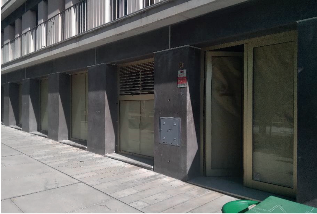
Fotografia da fachada
