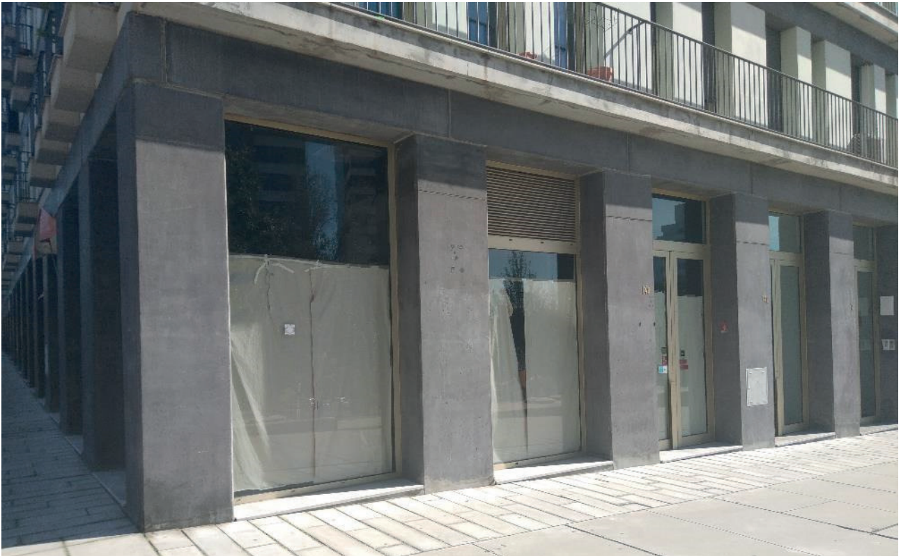
Fotografia da fachada
