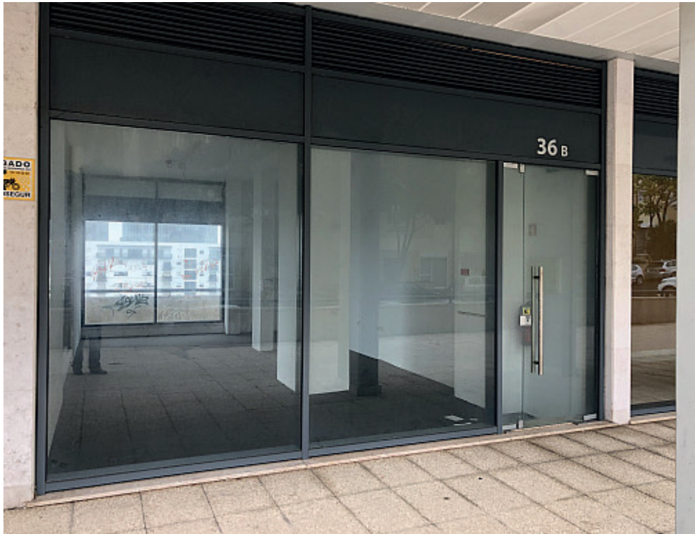
Fotografia da fachada
