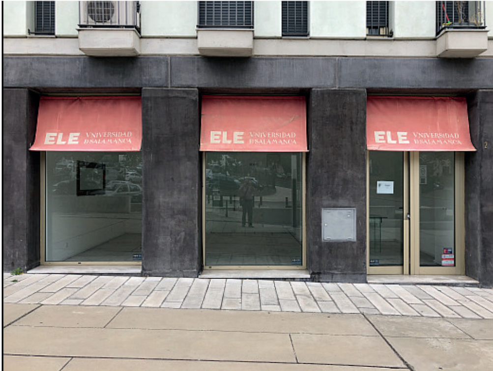
Fotografia da fachada
