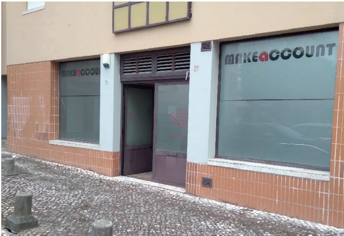
Fotografia da fachada
